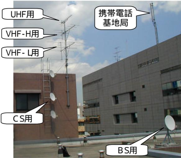
この例では、エレベータ塔屋支柱の上段にUHF用、中段にVHF高域用、更に下段にVHF低域用の合計3本のアンテナが設置されている。その左手には仮設のCS用パラボラ、写真の右端にはBS用パラボラアンテナが設置されている。なお、写真右上に見えるアンテナは、別ビルに設置された携帯電話基地局のアンテナである。この他にUHFを2カ所の送信アンテナから受ける地域ではUHF用アンテナを2本にし、FM用アンテナも設置しているマンションもあるので、どれが何だか分からなくなるのも不思議でない。
